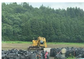
図6 除染によって生じた汚染土等の放射性廃棄物
